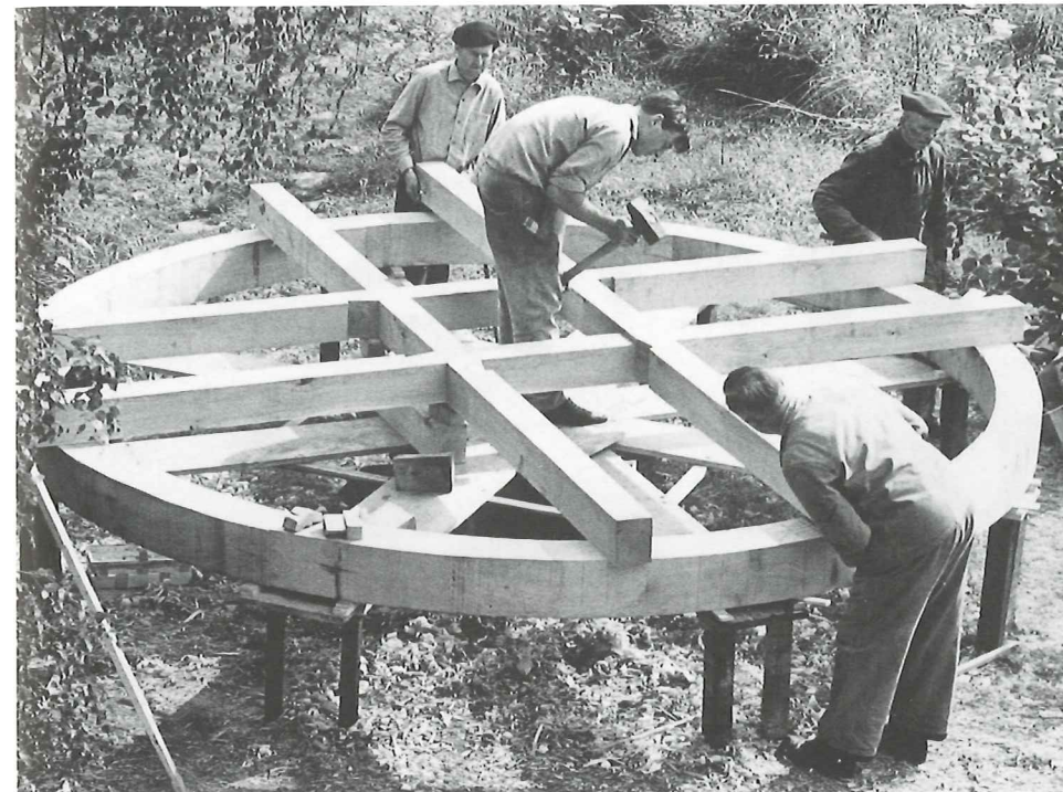
15. Bau eines neuen Wasserrades, 1964
